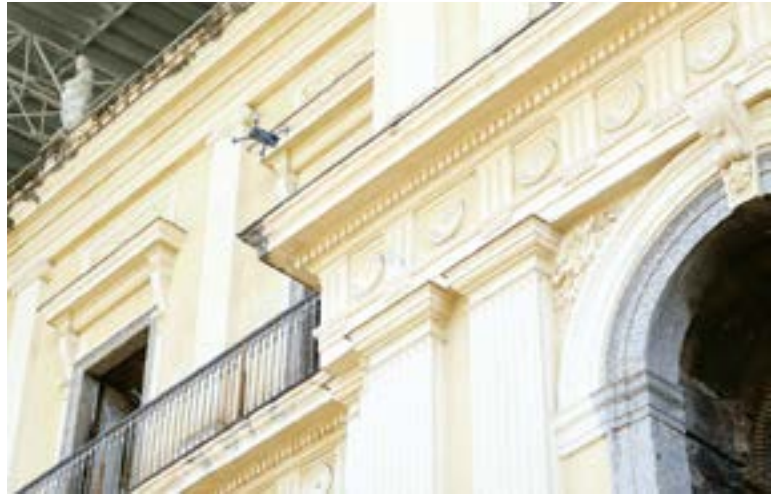
Processo de digitalização com drone da fachada frontal do Museu Nacional.
